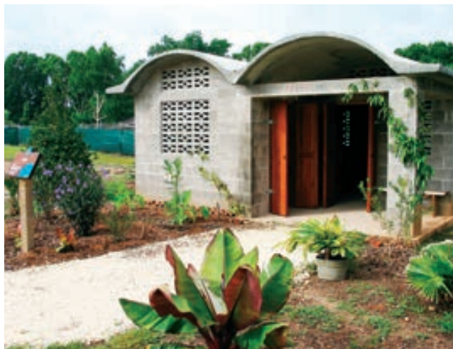
Esta modesta casa, hecha de bloques de concreto, se diseñó para usar en Haití por Hábitat para la Humanidad. Desde su fundación en 1976, Hábitat para la Humanidad Internacional ha construido más de 200,000 viviendas para un millón de personas en un centenar de países, como Estados Unidos.
